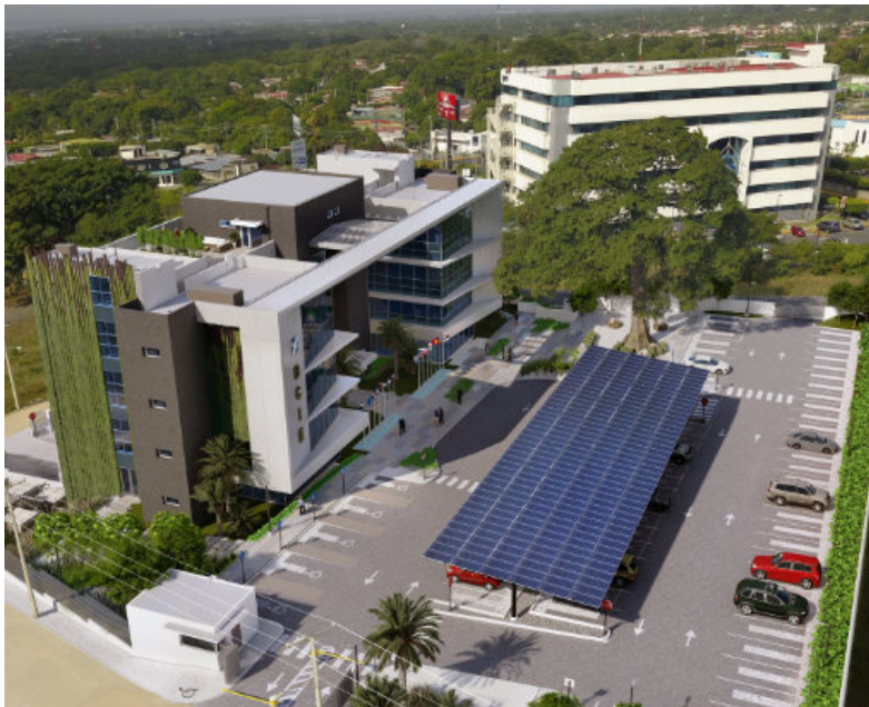
Azotea con paneles solares: sostenibilidad visible
